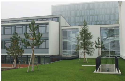
Die Kantonsschule Menzingen mit ihrem siebenstöckigen Schulneubau im Hintergrund.
